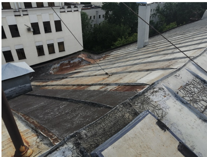
Фото 25. Коррозия жестяных листов покрытия. Растрескивание битумных материалов. Отсутствуют ограждение кровли
