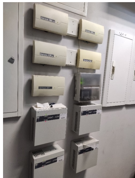
Фото 38. Моральный и физический износ оборудования АПС и СОУЭ
