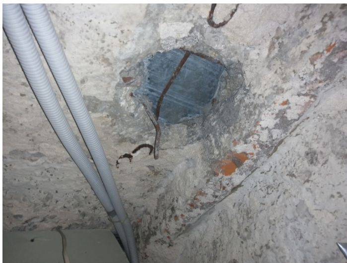
Фото 17. Сквозное отверстие в перекрытии
