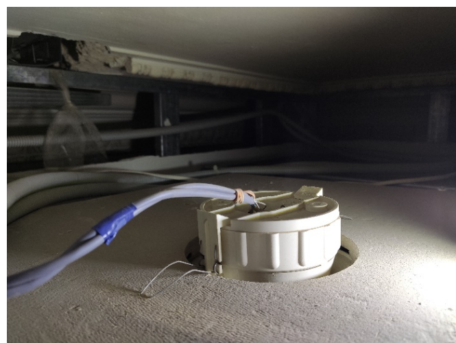
Фото 36. Несоответствие кабельной продукции требованиям пожарной безопасности
