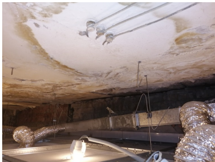
Фото 20. Следы замачивания атмосферными осадками перекрытия
