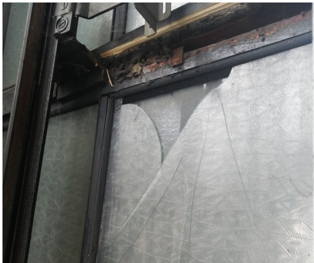
Фото 31. Разбито стекло. Гниение деревянных рам
