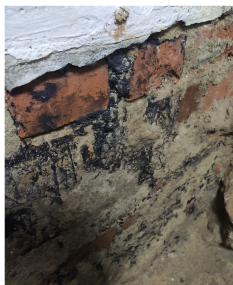
Фото 4. Отсутствие или потеря целостности гидроизоляции фундамента
