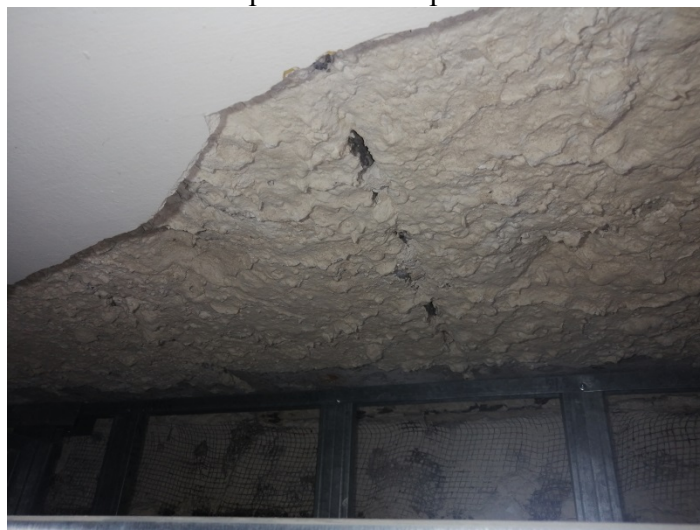
Фото 18. Участки отслоения штукатурного слоя на перекрытии
