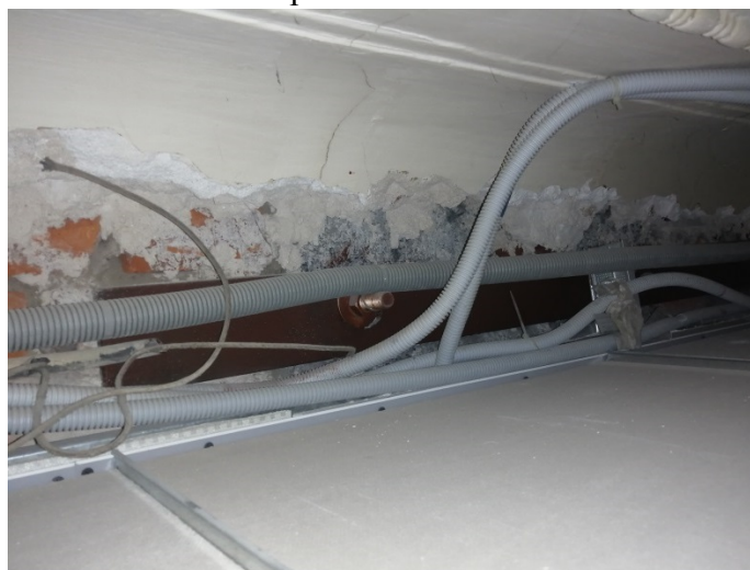
Фото 10. Волосяные трещины в стене
