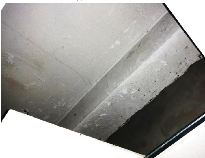
Фото 15. Поперечная трещина на нижней грани балки. Трещины в штукатурке перекрытия
