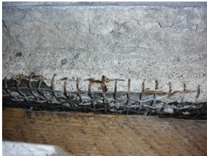
Фото 14. Отслоение штукатурного слоя балки с оголением сетки
