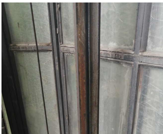
Фото 30. Повреждение коррозией металлического каркаса
