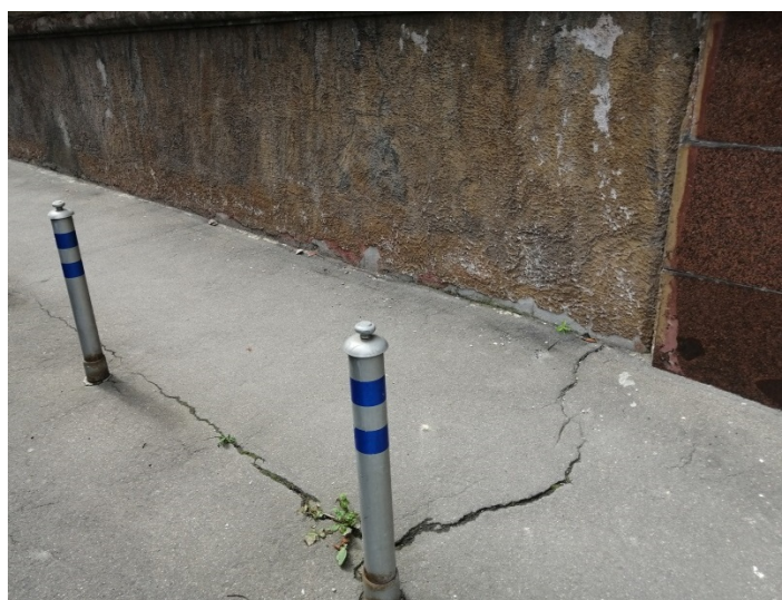
Фото 6. Трещины в отмостке и участки растительности на отмостке
