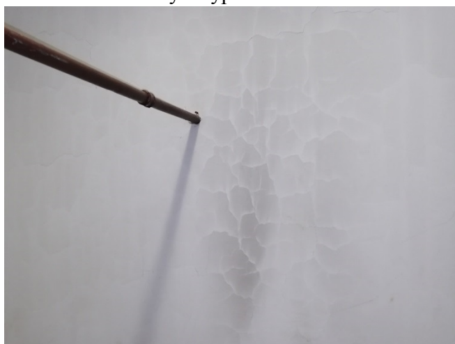
Фото 9. Хаотически расположенные трещины в штукатурном слое
