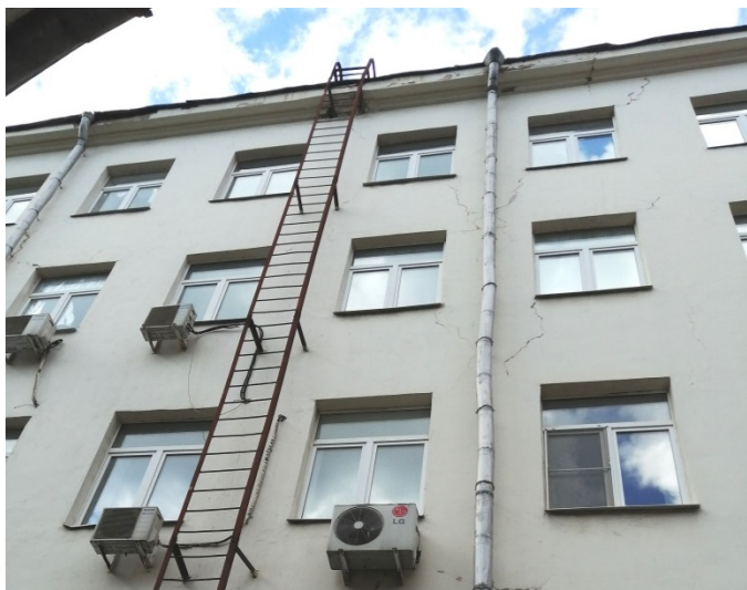
Фото 7. Сквозные трещины в стене
