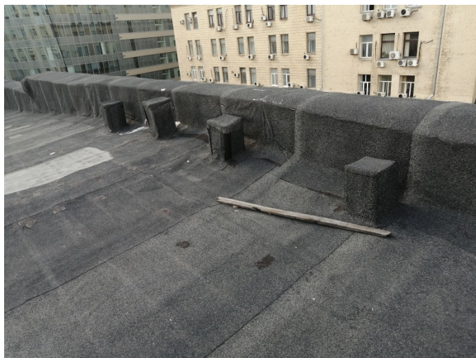
Фото 26. Вздутия рулонного ковра на отдельных участках. Отсутствуют парапетные сливы
