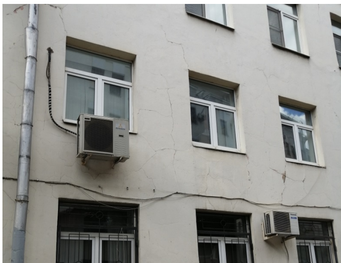
Фото 9. Хаотически расположенные трещины в штукатурном слое
