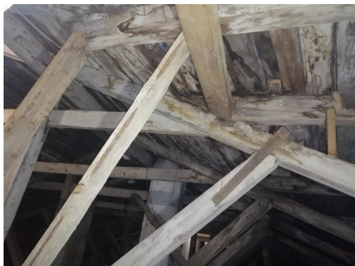
Фото 24. Повреждение плесневыми грибами деревянных конструкций
