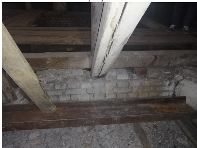
Фото 23. Растрескивание деревянных конструкций
