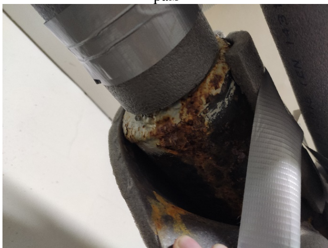
Фото 33. Коррозия магистралей системы водоснабжения
