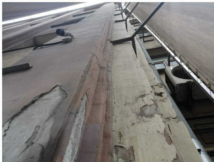
Фото 8. Участки отслоения штукатурного слоя разрушения защитного лакокрасочного покрытия на стене
