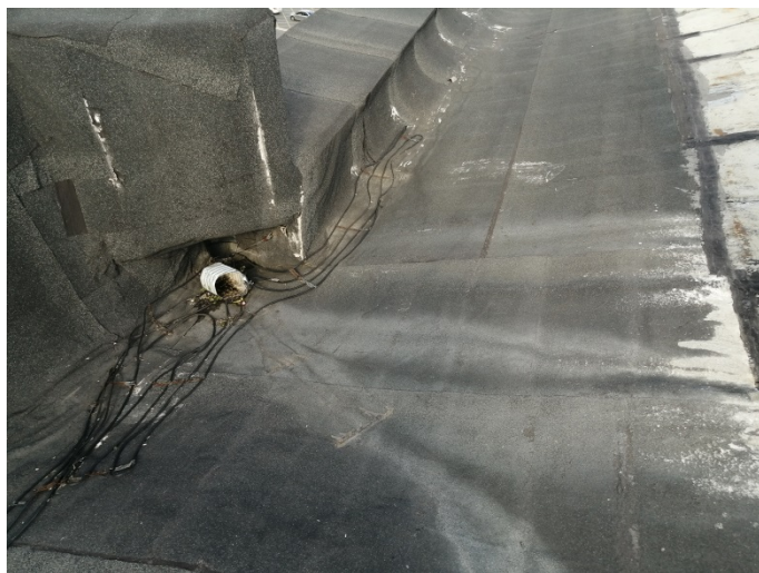
Фото 27. Засорены водоприемные воронки
