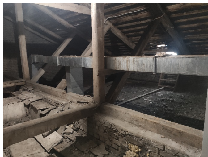
Фото 42. Не проведены мероприятия по уравниванию потенциалов на венткоробах и на вентоборудовании
