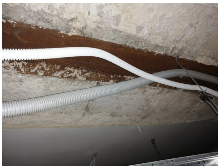
Фото 16. Балка повреждена равномерной коррозией и отсутствует защитное лакокрасочное покрытие
