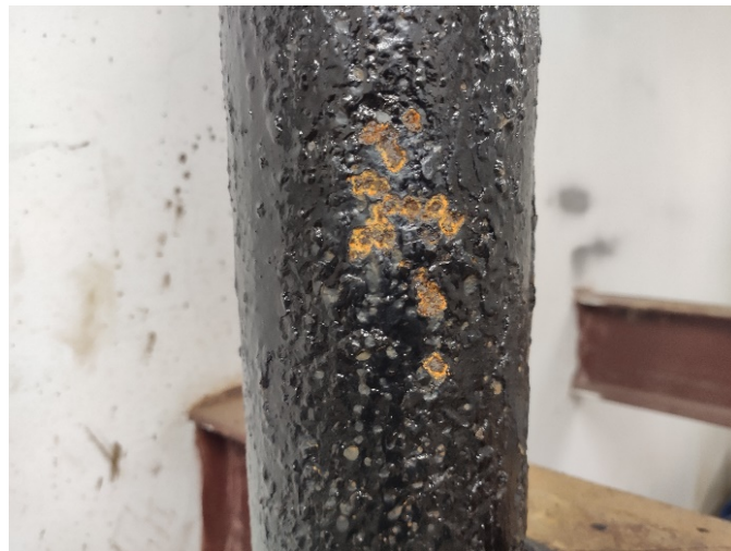
Фото 32. Коррозия подводящих трубопроводов
