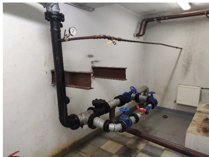
Фото 34. Отсутствует электрифицированная обводная задвижка и автоматика системы ВПВ
