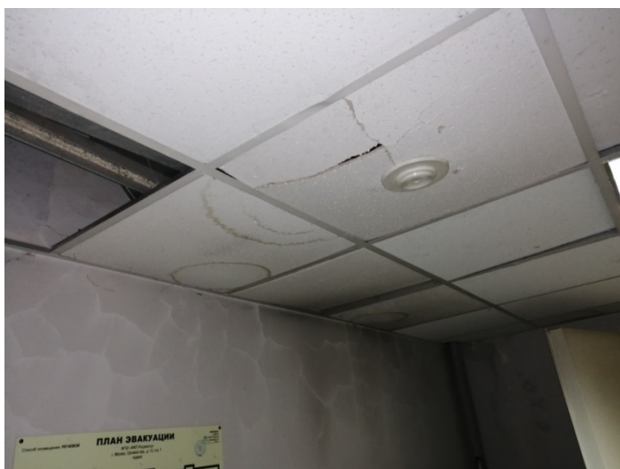
Фото 21. Сломаны отдельные потолочные плиты. Следы замачивания атмосферными осадками на перекрытии
