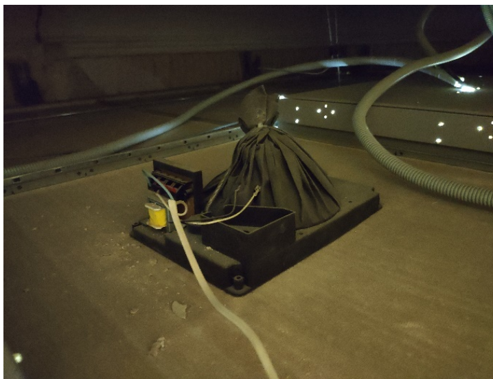
Фото 37. Несоответствие кабельной продукции требованиям пожарной безопасности
