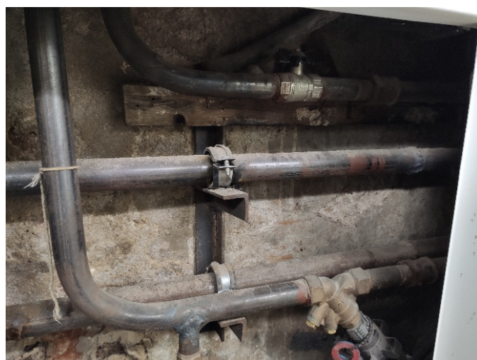
Фото 41. Коррозия труб подающих и разводящих магистралей, отсутствие теплоизоляции
