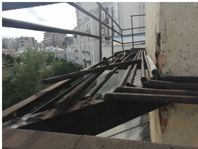
Фото 28. Разрушены ограждение и мостик для обслуживания кровли
