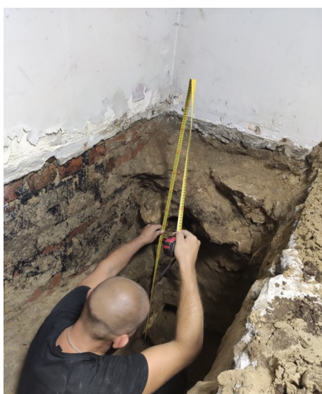
Фото 3. Шурфирование фундамента
