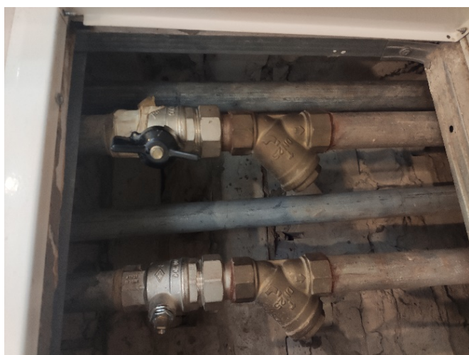
Фото 35. Отсутствие теплоизоляционного слоя
