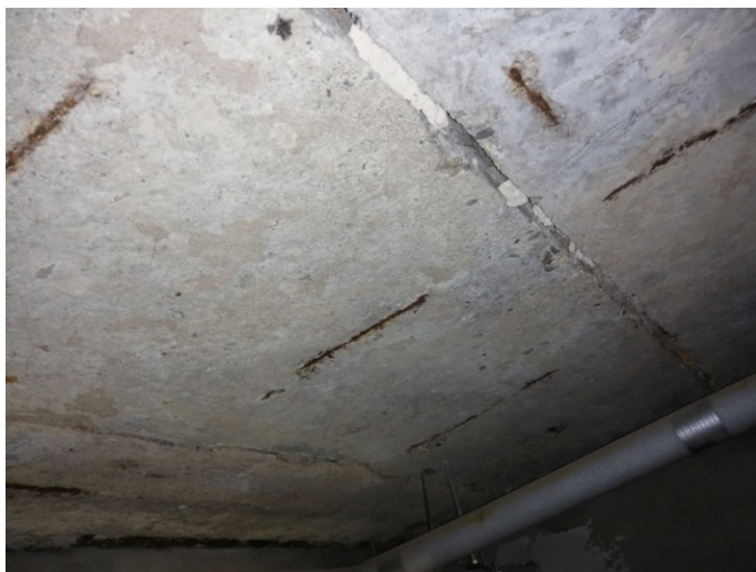
Фото 19. Участки отслоения защитного слоя бетона с оголением арматуры на плитах. Отслоение штукатурного слоя в швах между плитами
