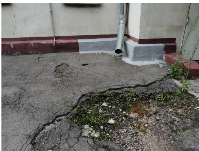
Фото 5. Неплотности между стеной и отмосткой
