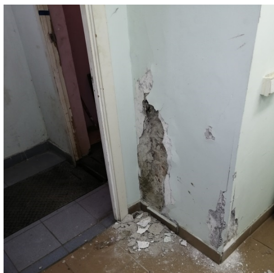
Фото 12. Отслоение штукатурного слоя на стене
